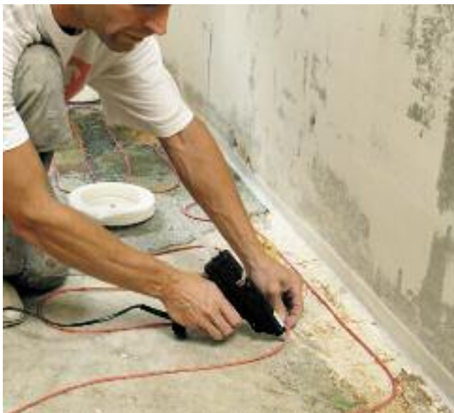
Kabeln på bilden fixeras med smältlim mot underlaget.
