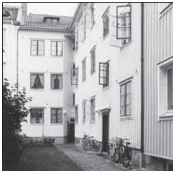
Gårdsinteriör Björcksgatan/Munkebäcksgatan (kv 38:20). Byggnaden har ursprungligt utseende med helt panelklädd fasad och spröjsade fönster mot gården.
