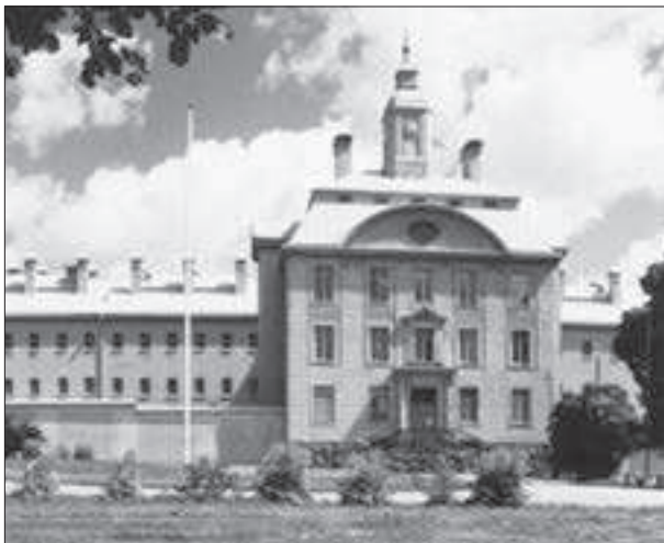
F d Hårlanda fångelse. I förgrunden entrébyggnaden och muren. Innanför muren f d cellbyggnaden.
