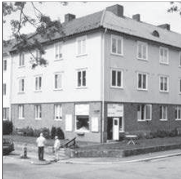
Björcksgatan (kv 38:15). Huset har ursprunglig bottenvåning av tegel, övervåningar klädda med ny panel och originalfönster utan spröjs.
